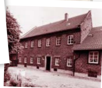
das ehemalige Verwalterwohnhaus, heute Verwaltung
